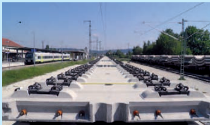
Gleisstragplatte „Feste Fahrbahn Bögl“ mit sichtbaren Stabenden der SAH Gewindestäbe SAS 500 für ICE-Hochgeschwindigkeitsstrecken der Deutschen Bahn
