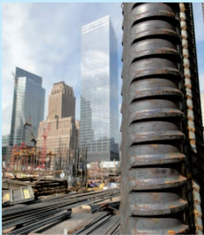
Bauarbeiten am „One World Trade Center“ in NY: hier ist der Gewindestahl SAS 670/800 für hochfeste Bewehrungstechnik und SAS 950/1050 für Spanntechnik im Einsatz
