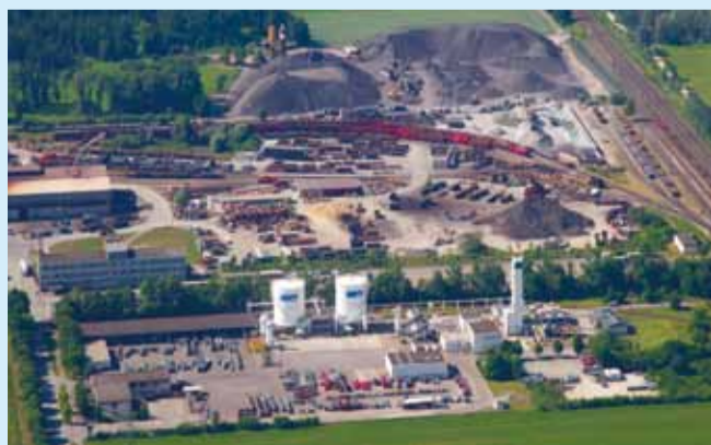
Schlackenlagerung und -verwertung bei der Max Aicher GmbH (MAH) am Standort Meitingen
