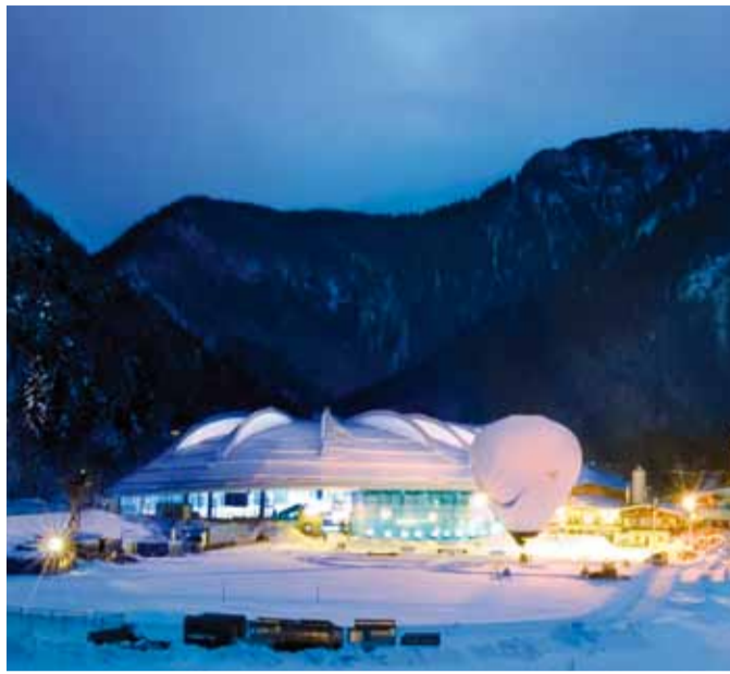
Die Max Aicher Arena in Inzell setzt neue Maßstäbe im Eisschnelllaufen und bietet Veranstaltungsmöglichkeiten für Events auf internationalem Niveau.
