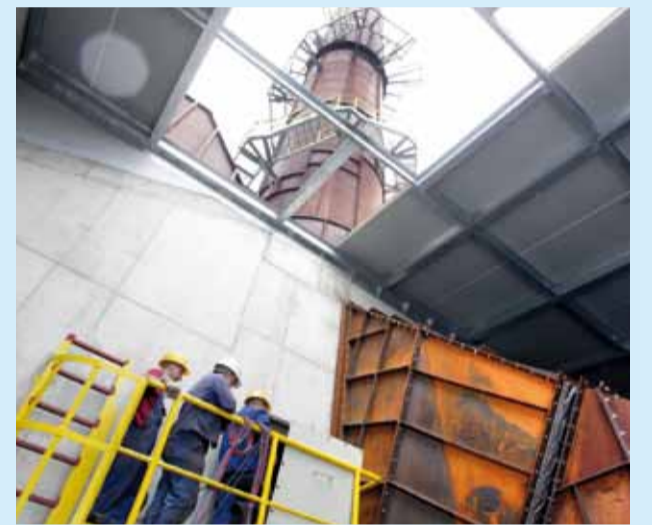
Bauarbeiten am Filter 4: eine der wesentlichen Maßnahmen zur Staubreduktion.
