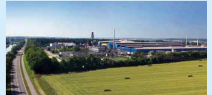
Blick auf das Werksgelände von LSW in neuer Farbgebung
